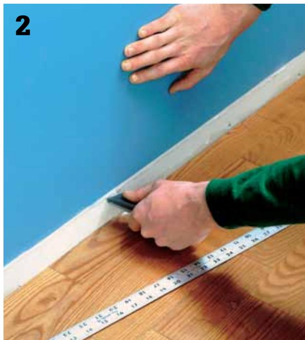
**2** Enlevez la plinthe située entre l'ancienne prise et la nouvelle. À l'aide d'un couteau universel, d'une scie sauteuse ou d'une scie à guichet, coupez une bande de panneau mural à environ 1 po du bord supérieur de la plinthe et enlevez-la.
