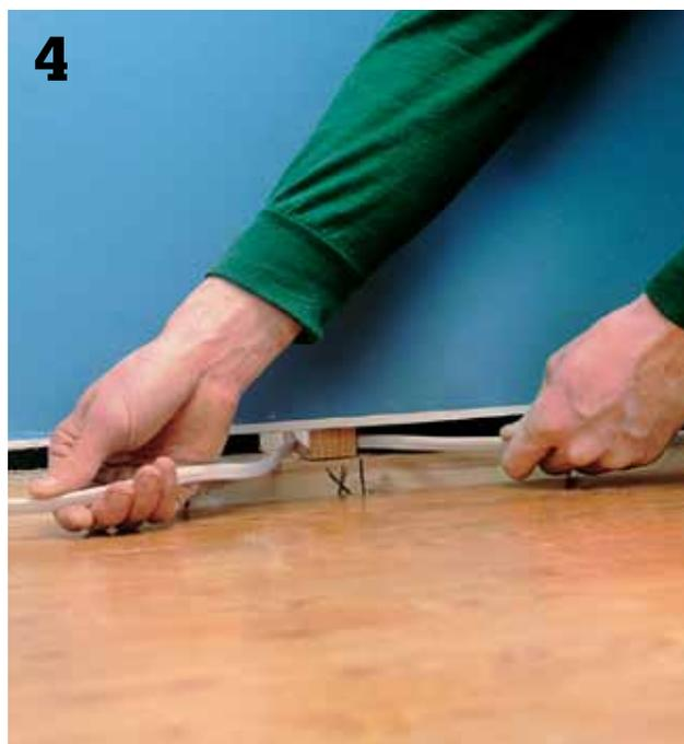
**4** Faites passer le câble dans les trous des poteaux de la nouvelle ouverture à l'ancienne prise. Agrafez le câble sur le poteau sous chacune des prises. Posez une plaque métallique de protection sur le bord avant de chaque poteau que traverse le câble.
