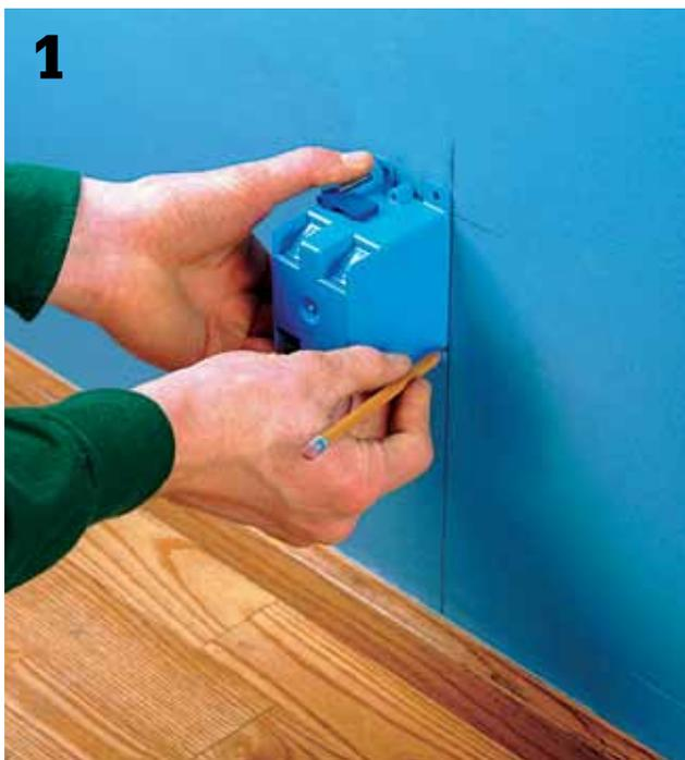
**1** Placez la nouvelle boîte à pattes de compression sur le mur et tracez-en le contour. Avant de couper le mur, assurez-vous qu'il ne contient pas de câbles ni de tuyaux.
